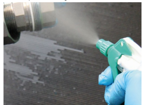
GS 200 aufsprühen – Dichtungsmasse entfernen
